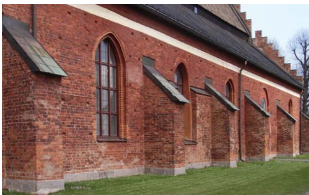
Figur 47. S:t Laurentii kyrka i Söderköping med strävpelare av tegel liknande de i Krokek Foto Marie Ohlsén, ÖLM.
